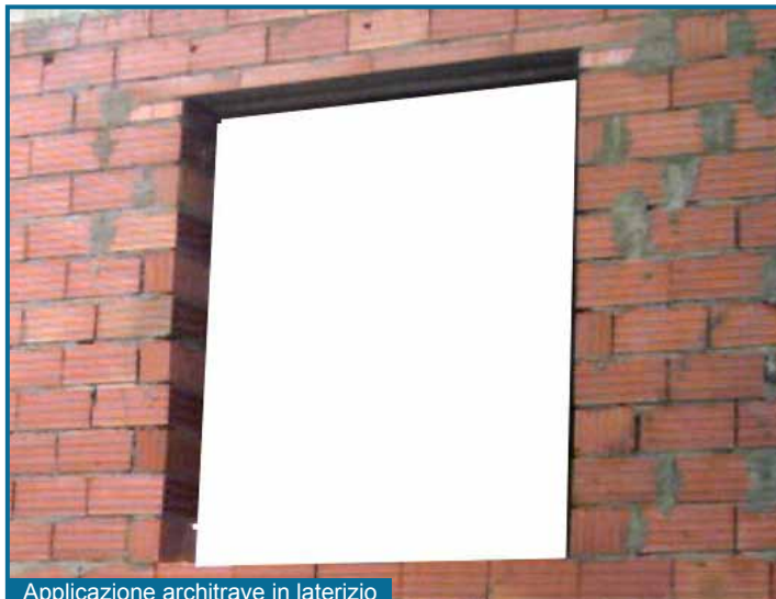
Applicazione architrave in laterizio
