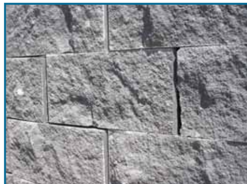
Esempio montaggio blocco splittato
