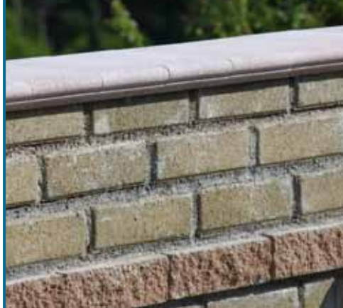
Muro blocchi smussato
