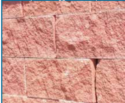
Esempio montaggio blocco splittato
