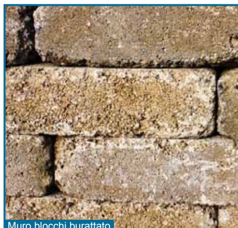
Muro blocchi burattato
