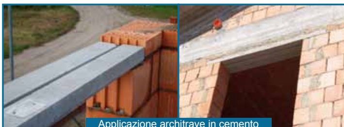
Applicazione architrave in cemento
