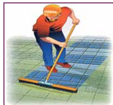
Fase 6 Rimozione della sabbia in eccesso
