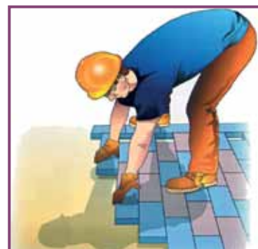
Fase 6 Rimozione della sabbia in eccesso
