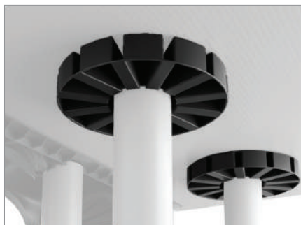
Rinforzo alla compensazione Reinforcement to compensation
